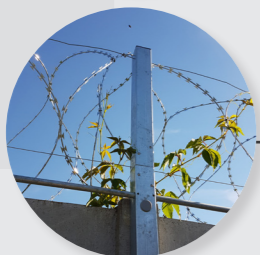
Bavolet droit avec barbelés sur haut de mur
